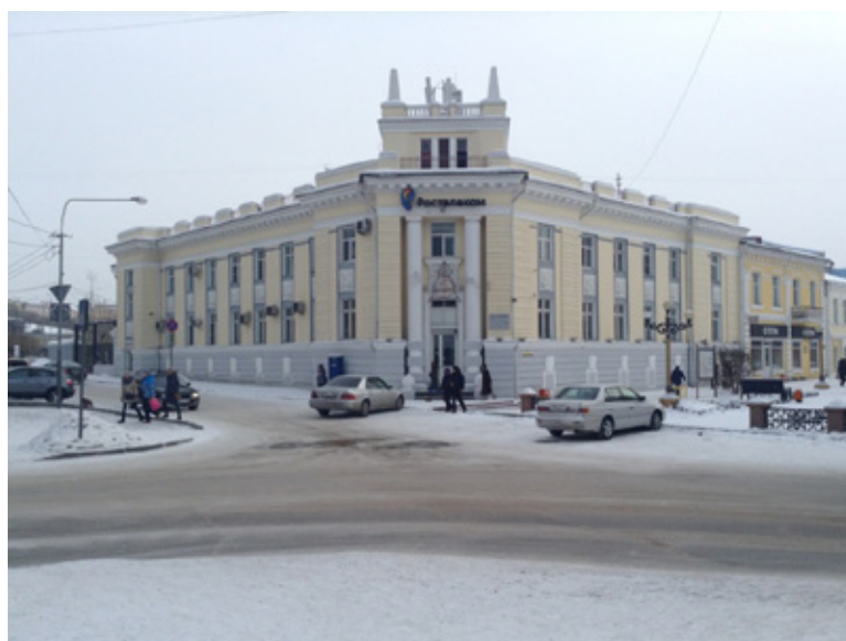
Рис. 2. Здание городской АТС. Архитектор Л. К. Минерт
